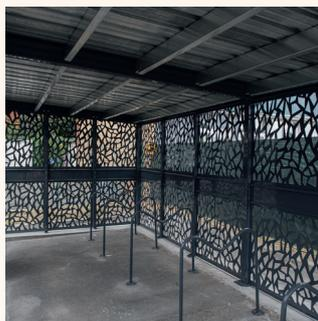
Arceau pour l'attache et le maintien des deux-roues légers, sans système de stabilité au sol (ex : béquille).
